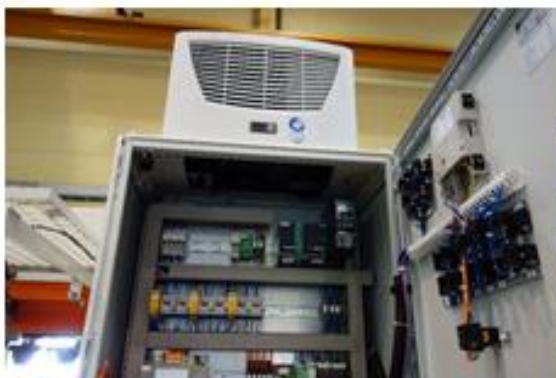
Armário elétrico com refrigeração por ventilação forçada
